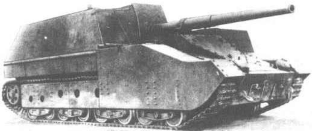
Figura 9: Uma peça auto propulsada Su-14-2 de 152mm. Os soviéticos experimentaram intensamente com artilharia autopropulsada nos anos 30, incluindo calibres pesados da artilharia de Corpo de Exército.
