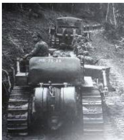
Figura nº 23 – Construção de uma estrada
