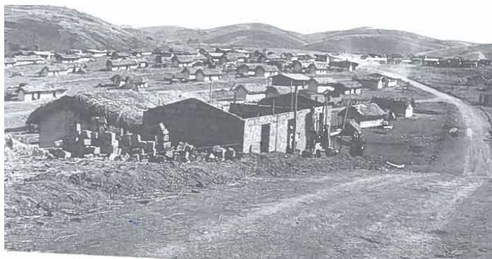
Figura nº 13 – Construção do Aldeamento de Banza-Puto (1969)
