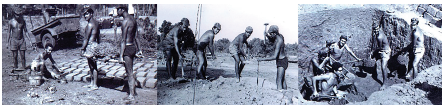
Figura 4 – Construção de abrigo em Guileje pela CCaç 726.
