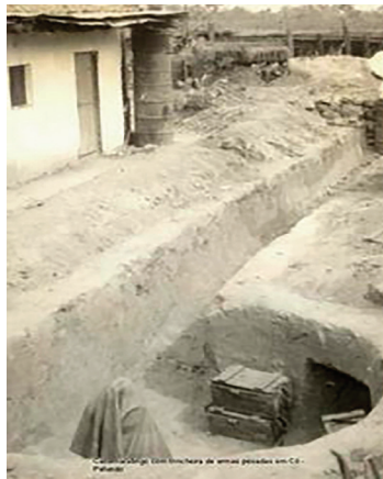
Figura 3 – Trincheira em Cói
