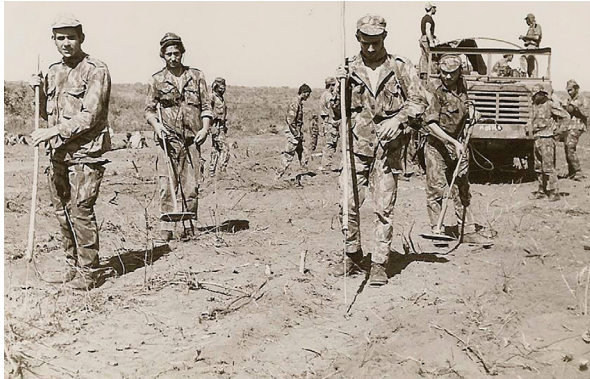
Figura 10 – Técnica de "picagem" manual
